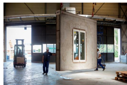
Paroi avant tests acoustique
