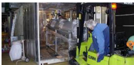
Construction d'un démonstrateur de traitement des eaux par cristallisation
